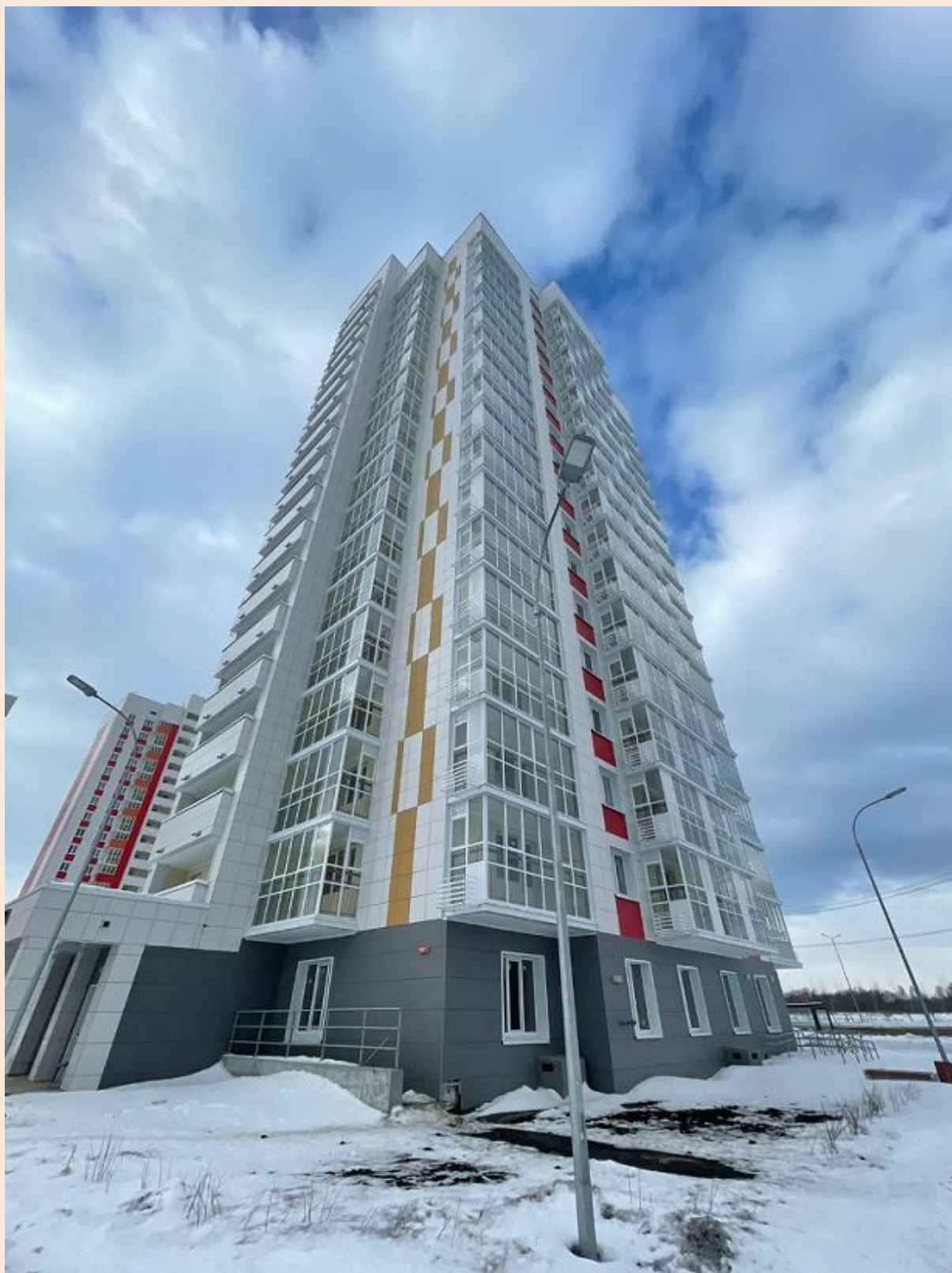
Объект: «102-квартирный жилой дом № 4-3 с нежилыми помещениями в жилом районе «Салават Купере» в г. Казани» (05.03.2022)
